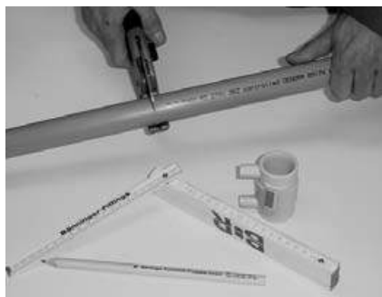
Fig. 1 Cortar el tubo en ángulo recto con respecto al eje del mismo con ayuda de una tijera cortatubo.
