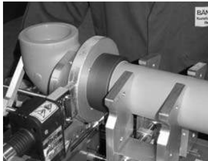
Fig. 9 Juntar los carros mediante la manivela, calentar el tubo y accesorio en los moldes de soldadura
