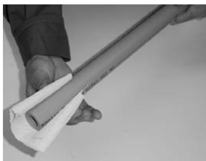
Fig. 4 Limpiar las superficies de fusión con un producto de limpieza.
