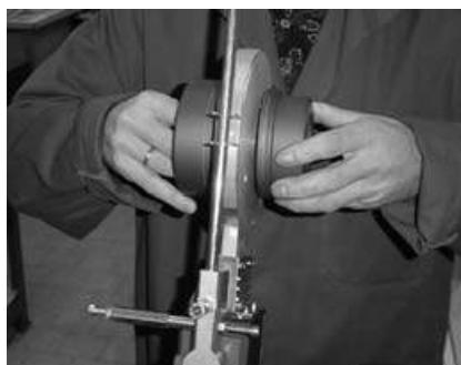
Fig. 2 Colocar el mandril y casquillo térmico en el espejo de soldadura
