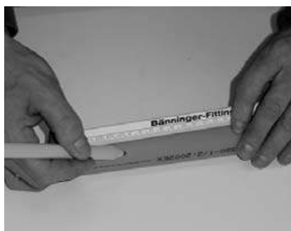
Fig. 5 Marcar la profundidad de inserción de la matriz.
