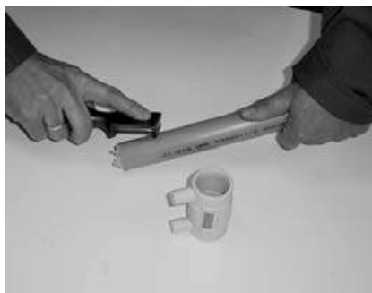
Fig. 2 Eliminar la capa de óxido exterior mediante con un raspador.
